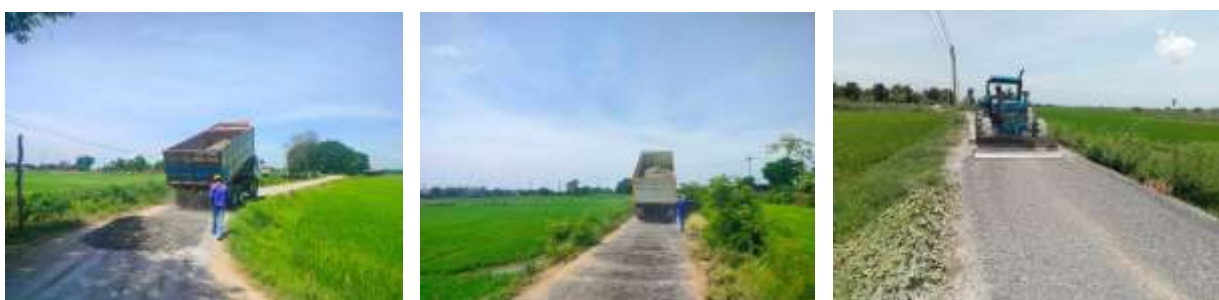
๒๔.โครงการลงหินคลุก หมู่ที่ ๔ จากจุดเชื่อมต่อถนนลาดยาง ถึงบ้านนายทองชูป พวงเข็มแดง
